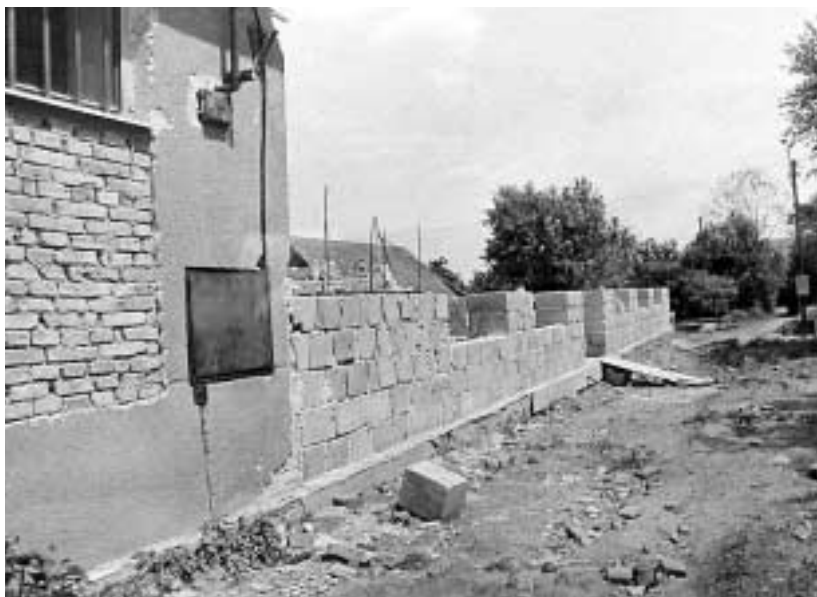
Staveniště – pohled od jihu
