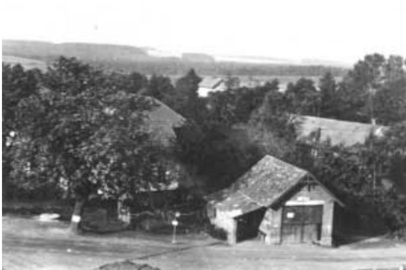
Původní hasičská zbrojnice, která byla po vybudování KD zbourána
