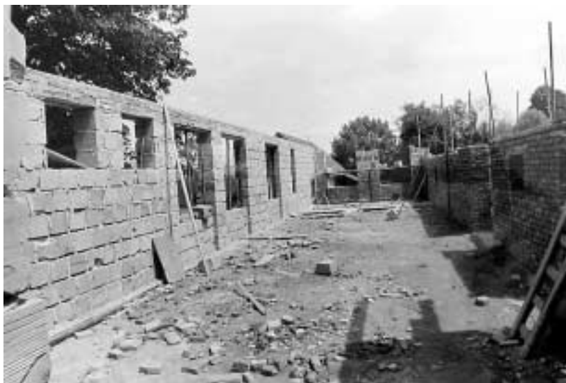
Staveniště vnitřku velkého sálu
