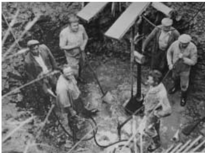
Záběr z výkopu rezervoáru na kopci Vizáb
